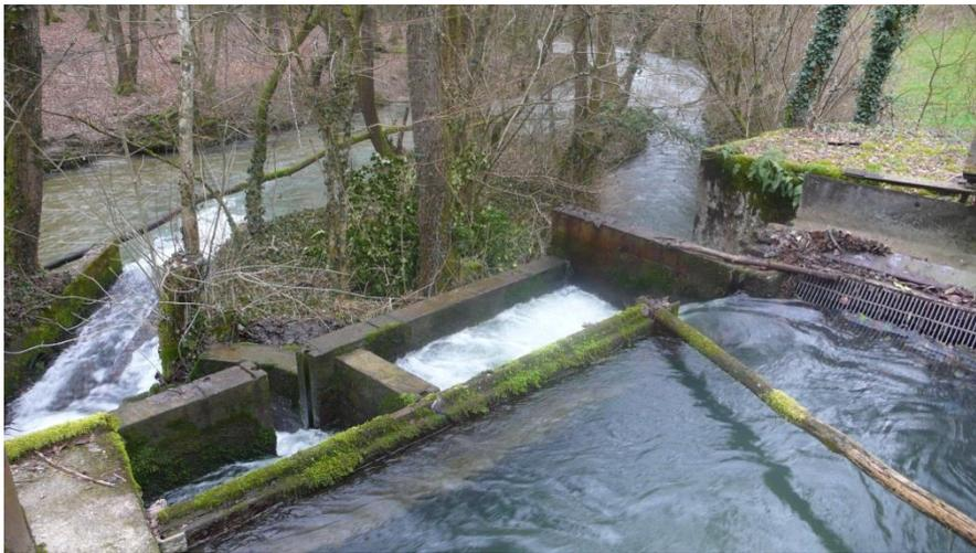
Canal de restitution du barrage (bras droit sur photo) et canal de surverse (bras gauche).
