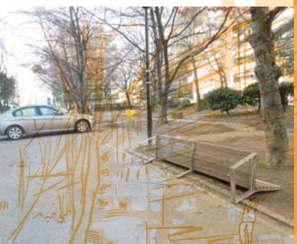
Le parc Russe, un espace mal entretenu et principalement dédié aux voitures avant la réalisation du mini-chantier
