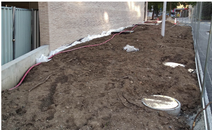
17. La fosse suite à la mise en place générale de la terre végétale
