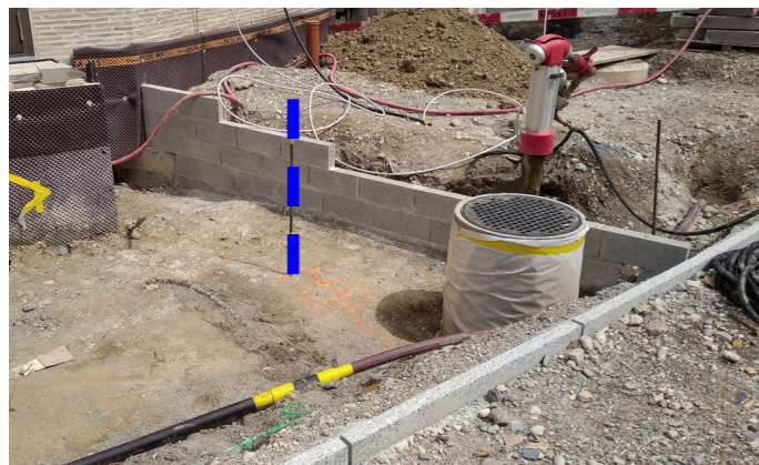
3. Au fond, le mur en parpaing protégeant les réseaux électriques. Au centre, le piquet marquant l'emplacement du futur arbre. À droite, le regard de diffusion (N°2). Le trait bleu indique la position du futur arbre.
