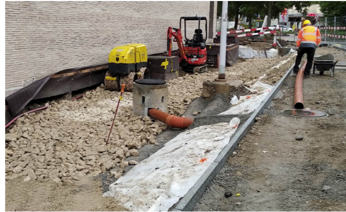
8. Mise en place de la première couche de cailloux et passage du pied de mouton
