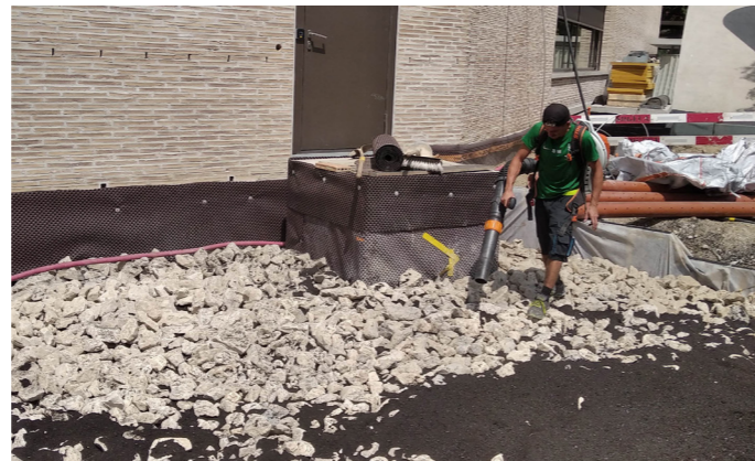
12. Utilisation du souffleur pour incorporer le mélange compost / biochar
