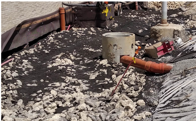
9. Aspect général de la fosse après réalisation de la première couche de base
