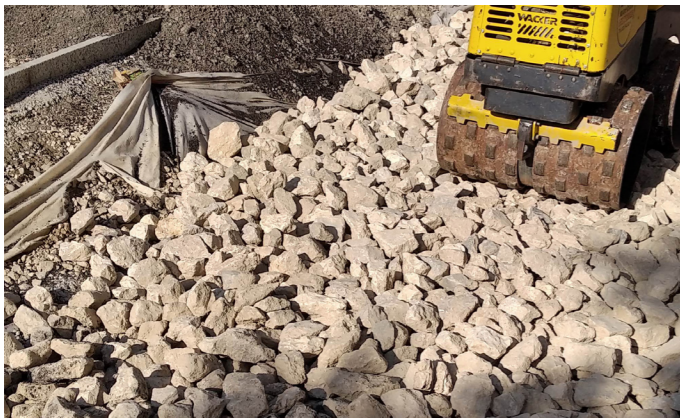
11. Mise en place de la seconde couche de cailloux
