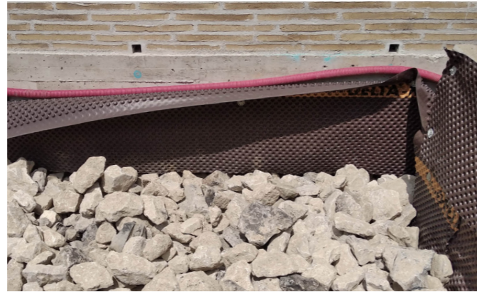
14. Le mélange n'a pas été mis en place au pied de façade pour ne pas encourager le développement des racines vers le bâtiment
