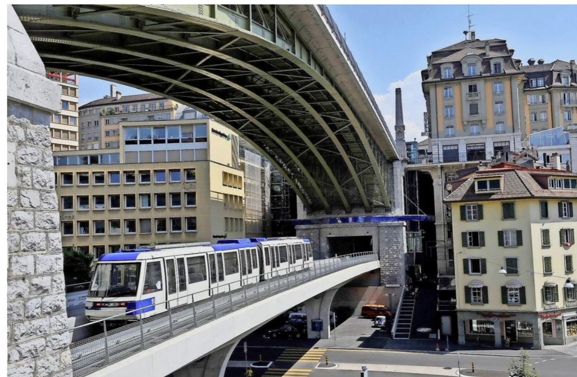
Le canton de Vaud a réussi à démontrer la pertinence de coupler les travaux d'amélioration du M2 et la création du M3 au chantier concernant la gare de Lausanne. KEYSTONE
