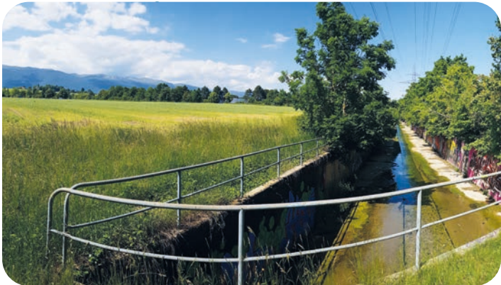
Canalisé sur certains tronçons, ici à proximité voies CFF
