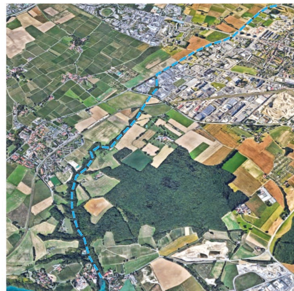
Figure 1 : Vue aérienne du Nant d'Avril entre Meyrin et Peney
