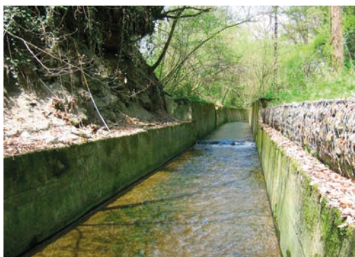
Figure 1 : Écoulement du nant dans un corset en béton (partie aval)
