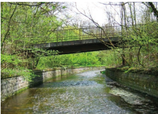
Figure 1 : lit et berges artificialisés sur la partie aval
