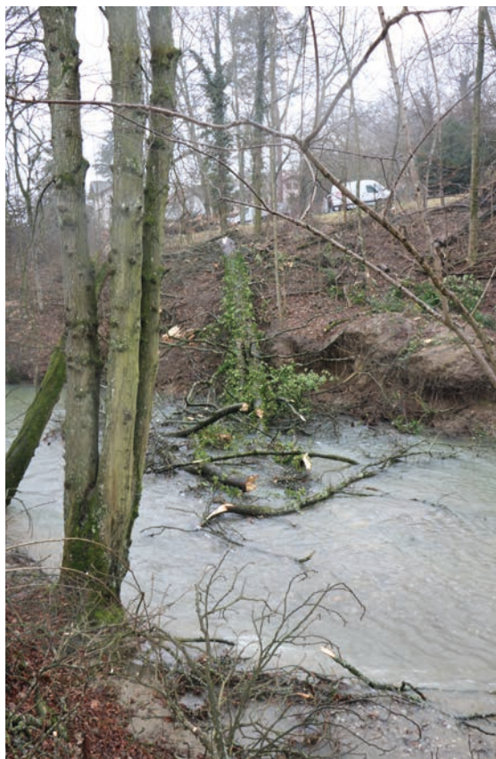
Figure 2 : Travaux contre l'érosion des berges
