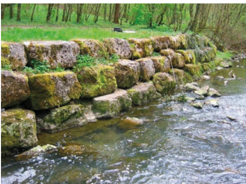
Figure 2 : Ouvrage de protection des berges sur la partie amont
