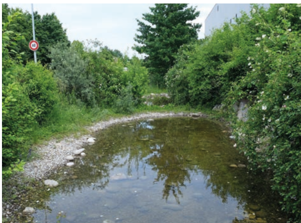
Noue pour la rétention des eaux pluviales (route de Satigny, ZIBAT)
