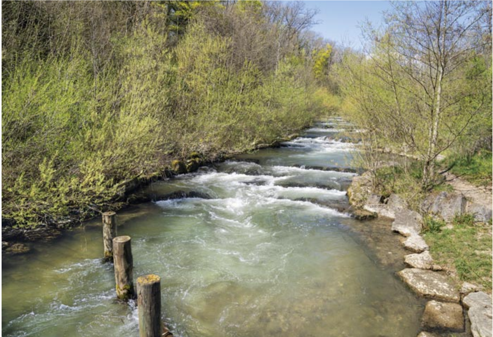
L'ancienne passe à poissons a été remplacée par une succession de bassins. Au premier plan, un râtelier bloque les troncs avant la ville de Versoix, 2020
