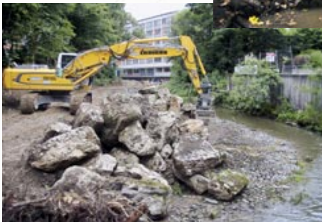
En amont de la rue de Chêne-Bougeries, avant les travaux, le lit est entièrement bétonné, 2010
