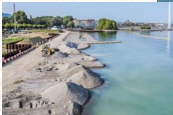
Mise en place du gravier sur la nouvelle plage, 2018
