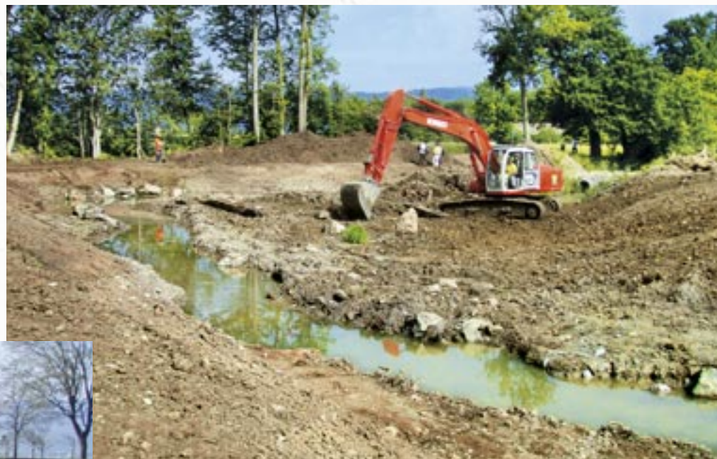
En aval du pont Neuf, réactivation d'un ancien méandre de la rivière, 2010
