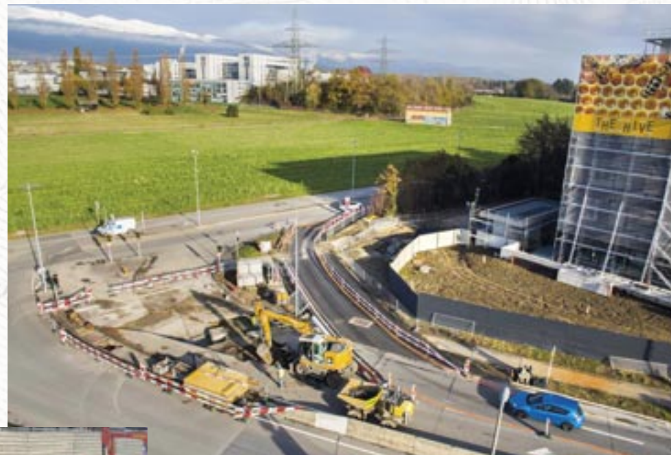
Travaux au carrefour du Nant d'Avril et de la route du Mandement, 2016
