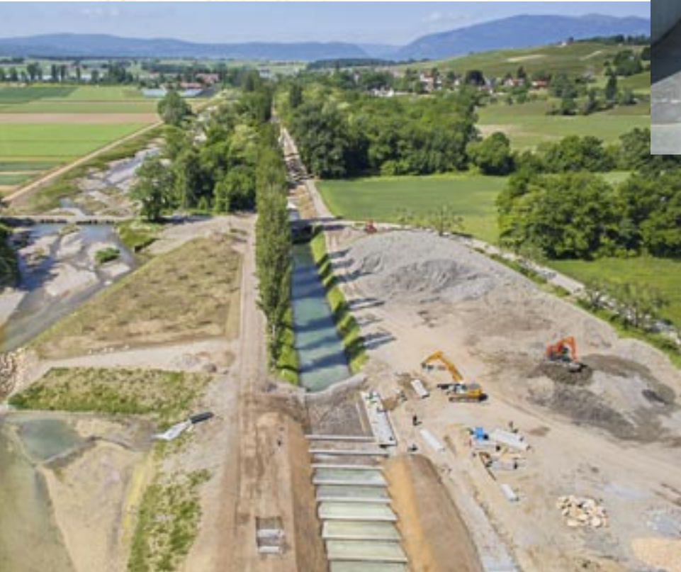
Fin de chantier à Moulaz (Confignon) : jardin d'eau, fosse et losanges, 2015
