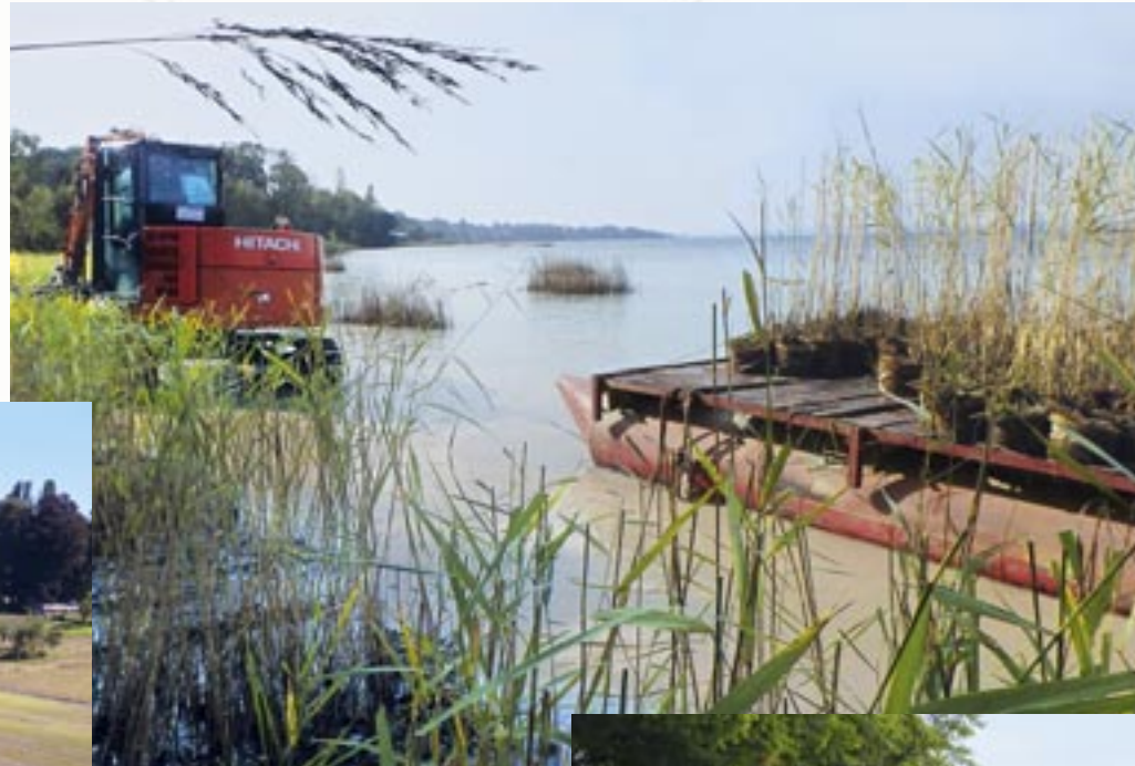
Mise en place des roseaux, 2015
