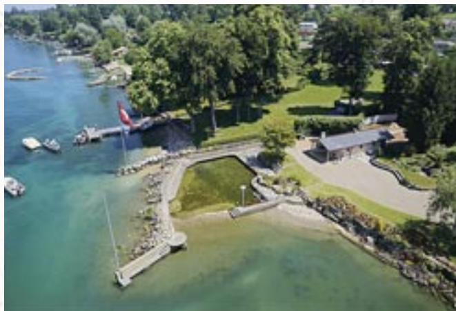
L'embouchure du nant et le port avant la démolition, 2015
