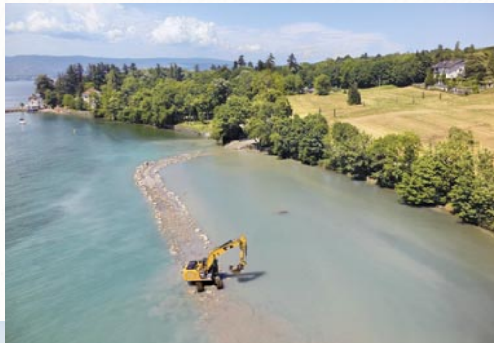
Construction de sabot de protection en enrochement, 2015
