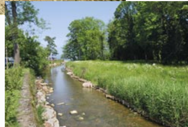
Traversée du village d'Hermance deux ans après les travaux
