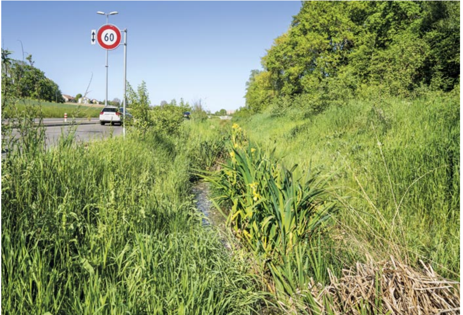
Deux ans après les travaux, la nature s'exprime, 2020
