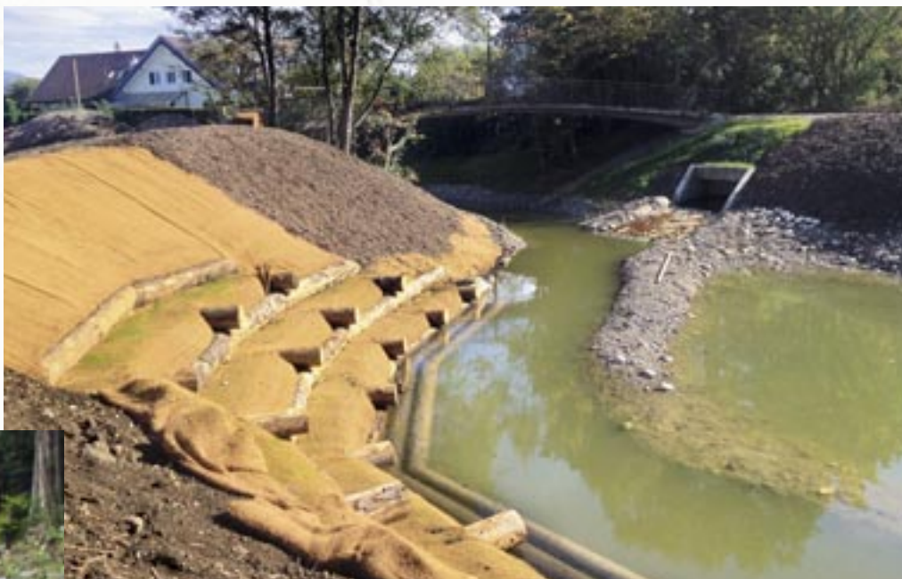
En aval du pont Bochet, aménagement d'un caisson végétalisé équipé de sous-berges pour la faune piscicole, 2014
