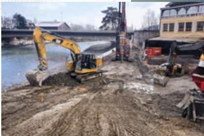
Construction du mur en pieux sécants pour protéger le bâtiment des inondations en aval du pont de Sierne, 2017
