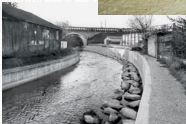
Versoix urbaine : état avant la renaturation, 2000
