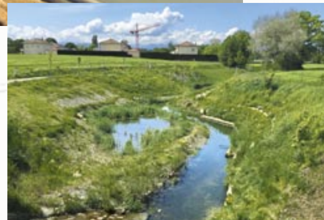
En aval du pont Bochet, deux ans après les plantations, le caisson a disparu sous la végétation, 2017
