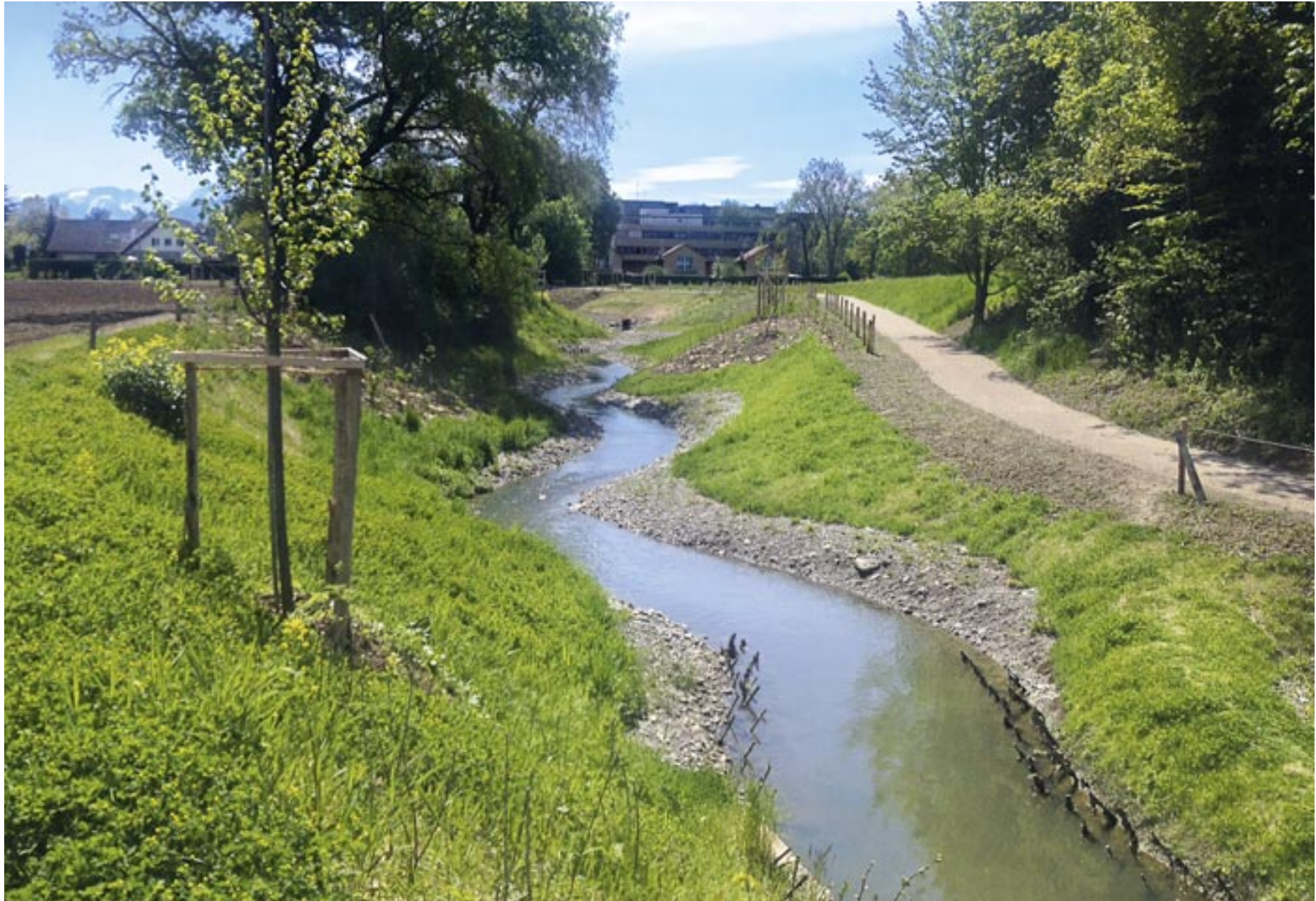
Nouveaux méandres en aval du pont Bochet, 2015
