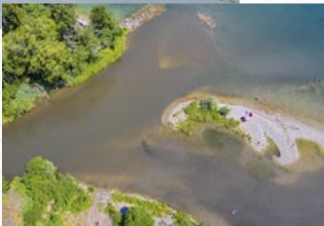
L'embouchure de la Versoix après les travaux, 2019
