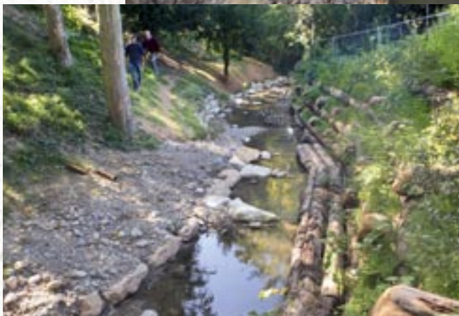
Construction de caisson en bois avec la cache piscicole en amont du chemin du Nant d'Aisy, 2015
