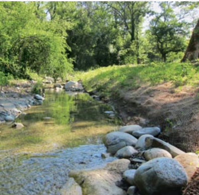
Ruisseau de Pralieu, restructuration du lit, 2019
