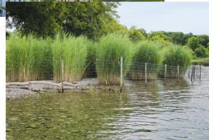
La roselière terrestre à la fin des travaux, 2015
