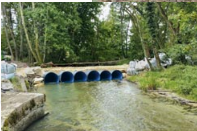
Passage de la Versoix pour permettre la réalisation des travaux sur le canal, 2019
