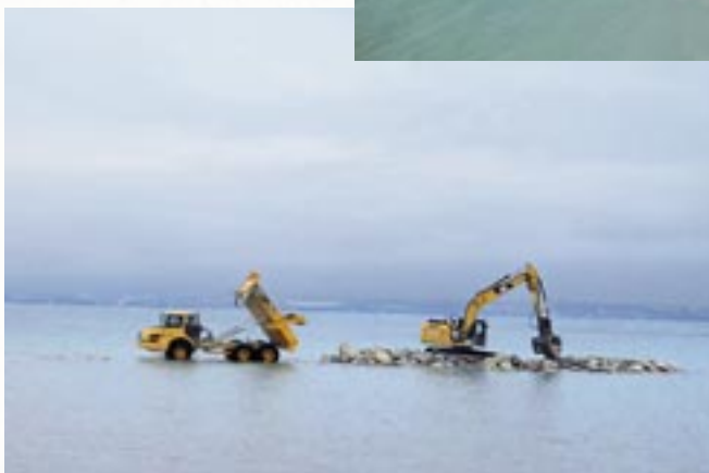
Construction de sabot de protection en enrochement, 2015
