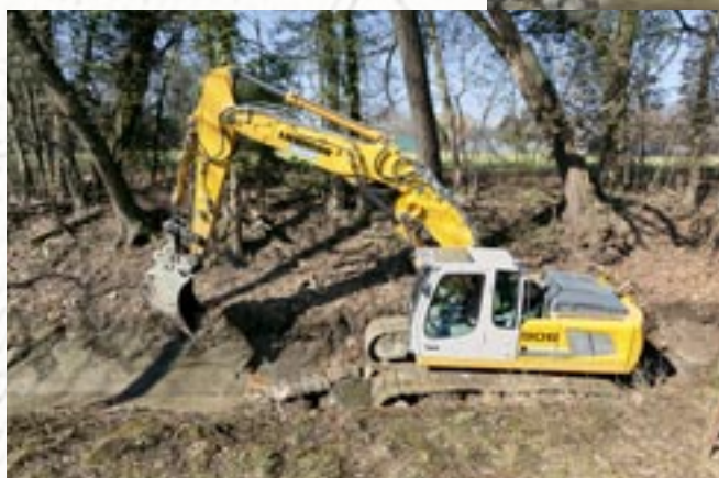
Démolition du béton du canal à Choulex, 2008
