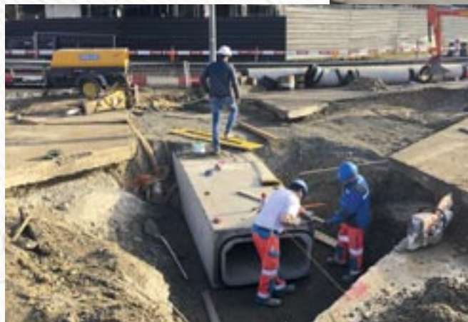
Passage du nant sous la route du Nant d'Avril, 2016
