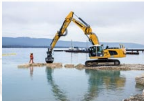
Construction des épis pour « tenir » la plage
