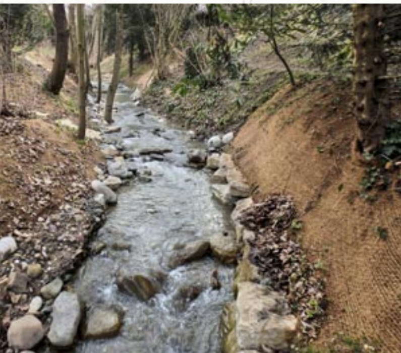
Reprise des berges et structuration du lit en aval de la route d'Hermance, 2015
