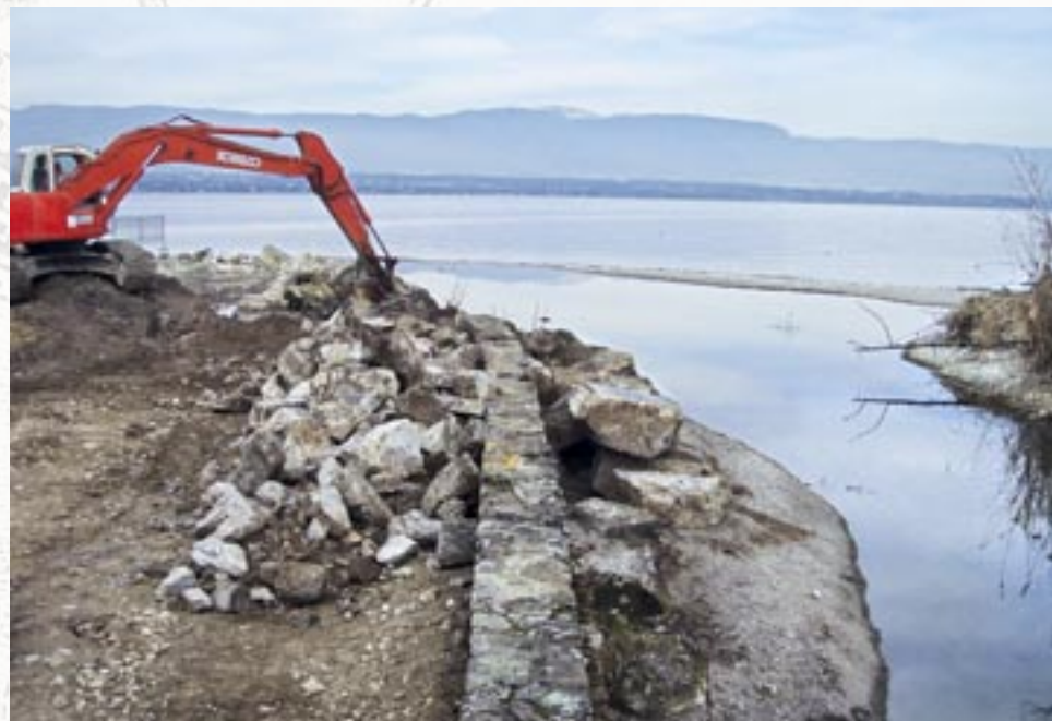
Embouchure, démolition d'une partie du mur de protection du camping, 2011
