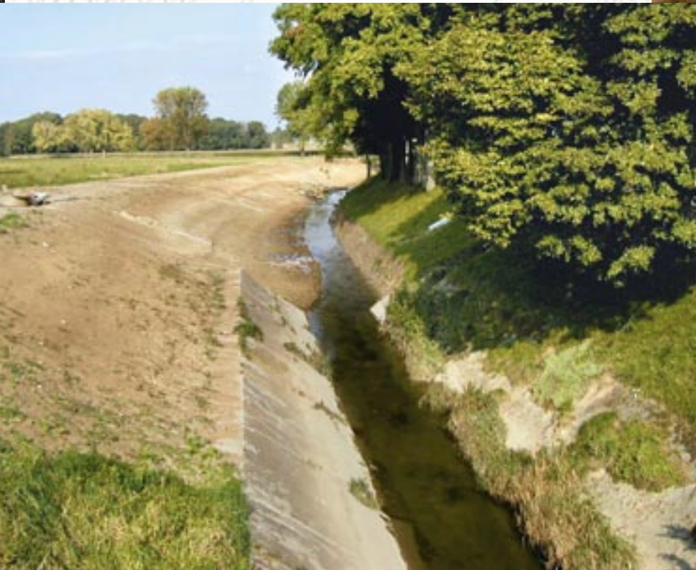
Démolition du canal en béton et abaissement de la berge en rive droite, 2008
