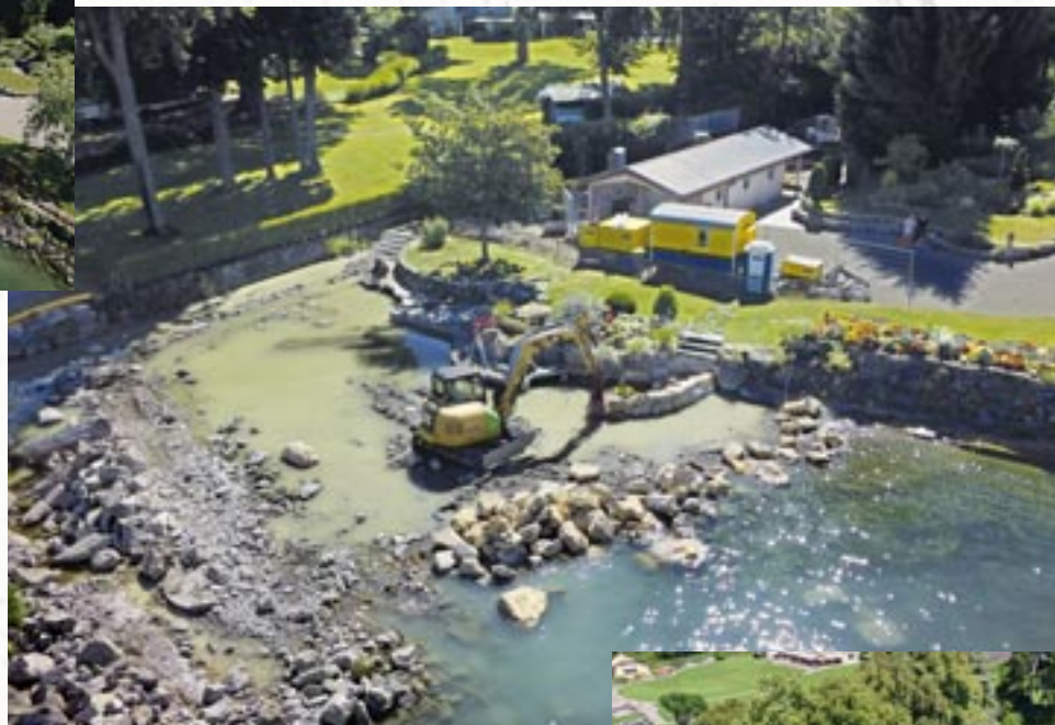
Le port en cours de démolition, 2015
