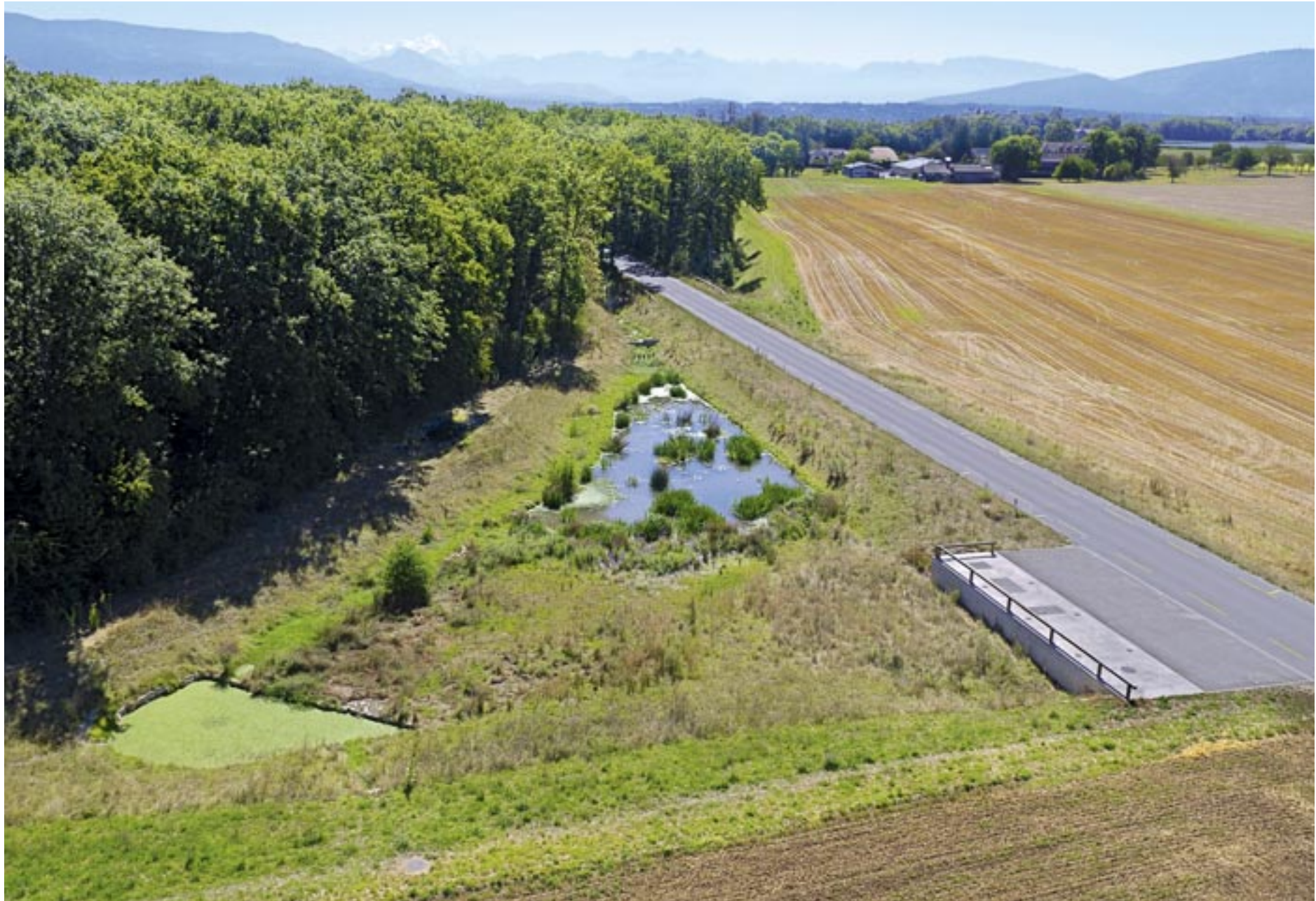
Bassin paysager de gestion des crues, avec à droite l'ouvrage de traitement des eaux de l'autoroute, 2020
