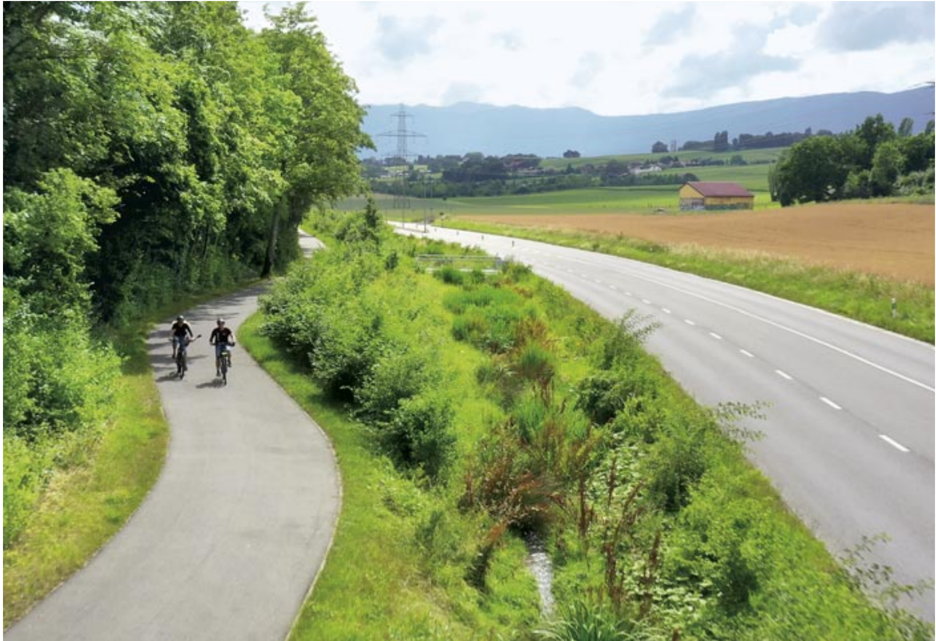
Remise à ciel ouvert du Nant d'Avril le long de la route du Mandement, 2020
