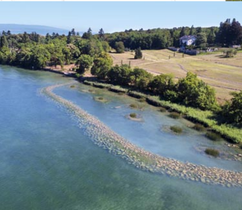
La roselière à la fin des travaux, 2015
