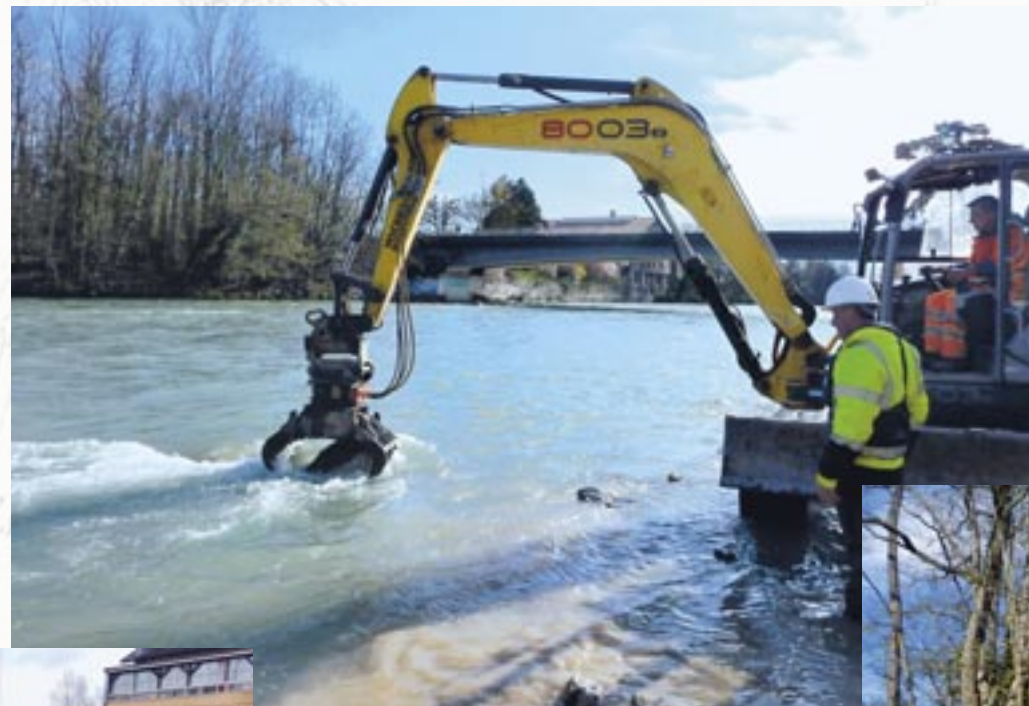
Mise en place d'enrochements pour servir de caches piscicoles, 2018
