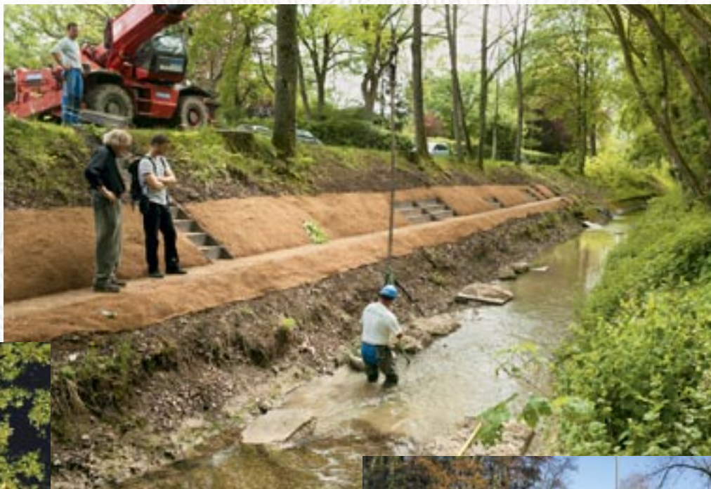
Travaux de diversification du lit à côté de la prison de Champ-Dollon, 2012
