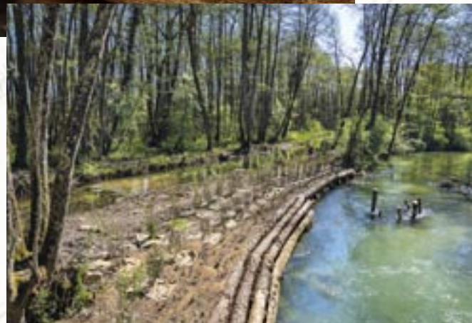
Caisson en bois avec cache piscicole à la fin des travaux de plantations, 2020
