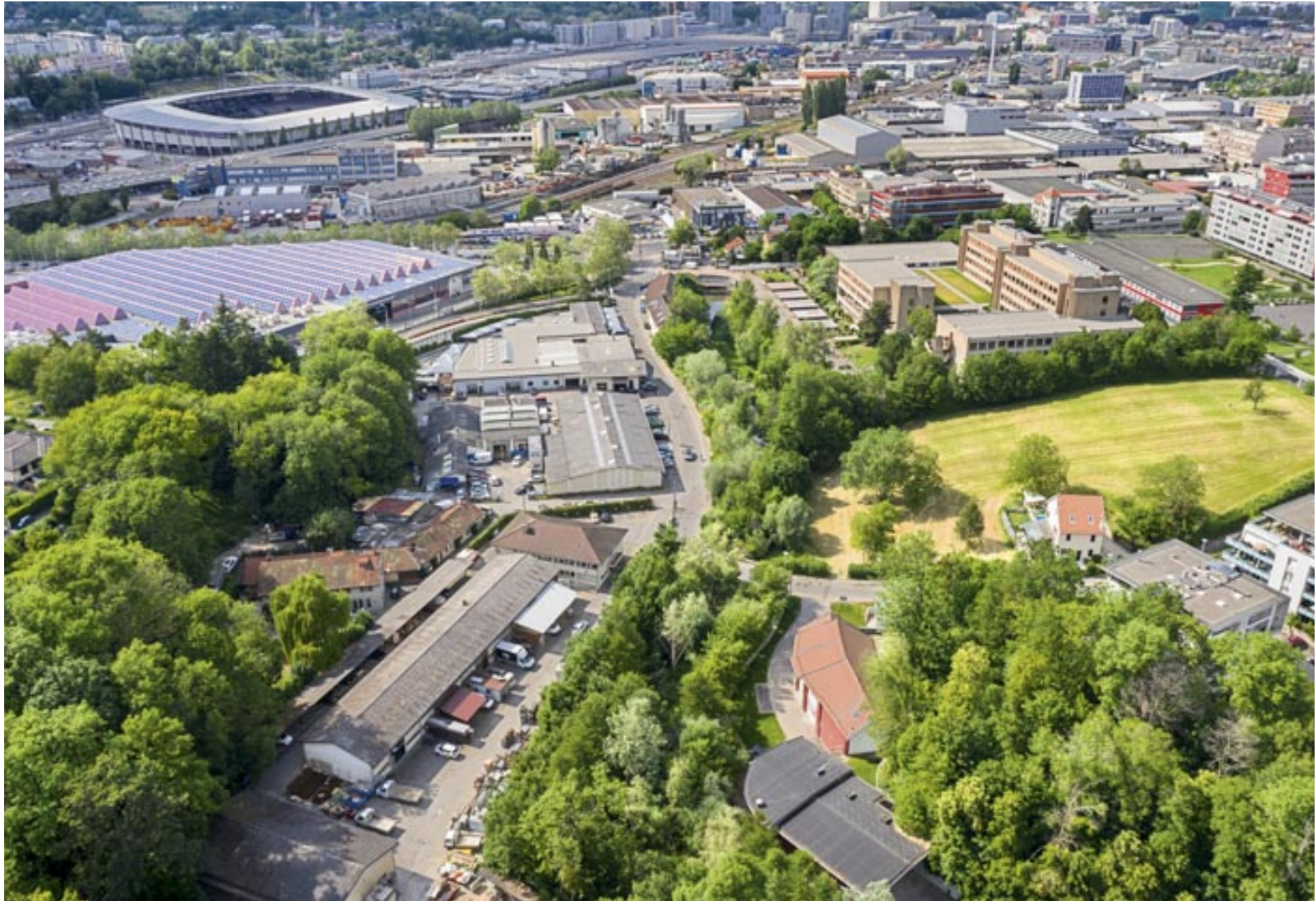
La Drize et son cordon boisé à Grange-Collomb avant son passage en tunnel dans le quartier Praille-Acacias-Vernets, 2019
