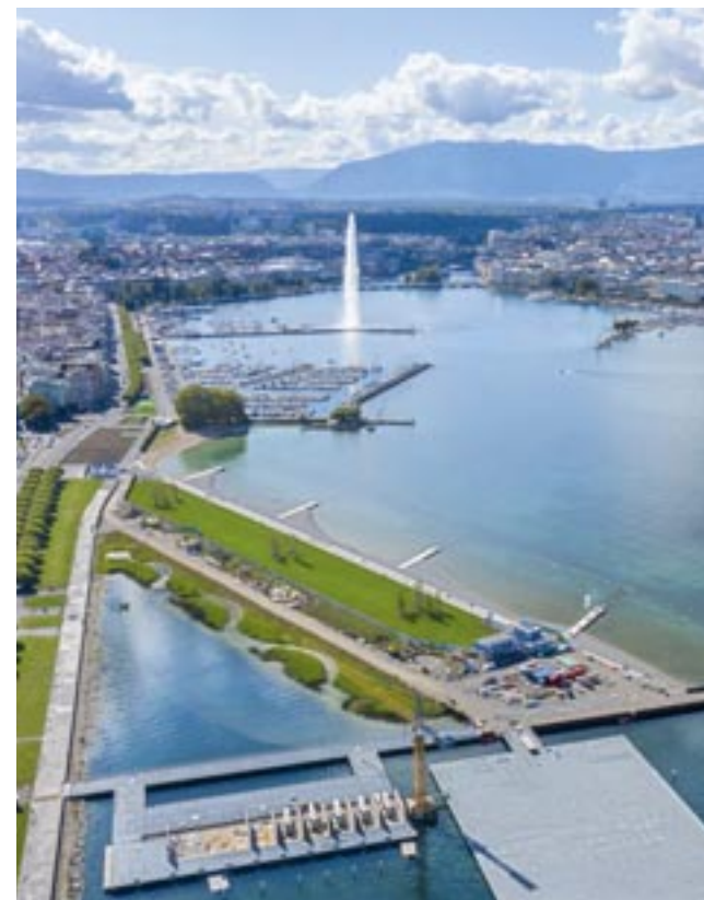
La plage des Eaux-Vives en cours de chantier, 2019
