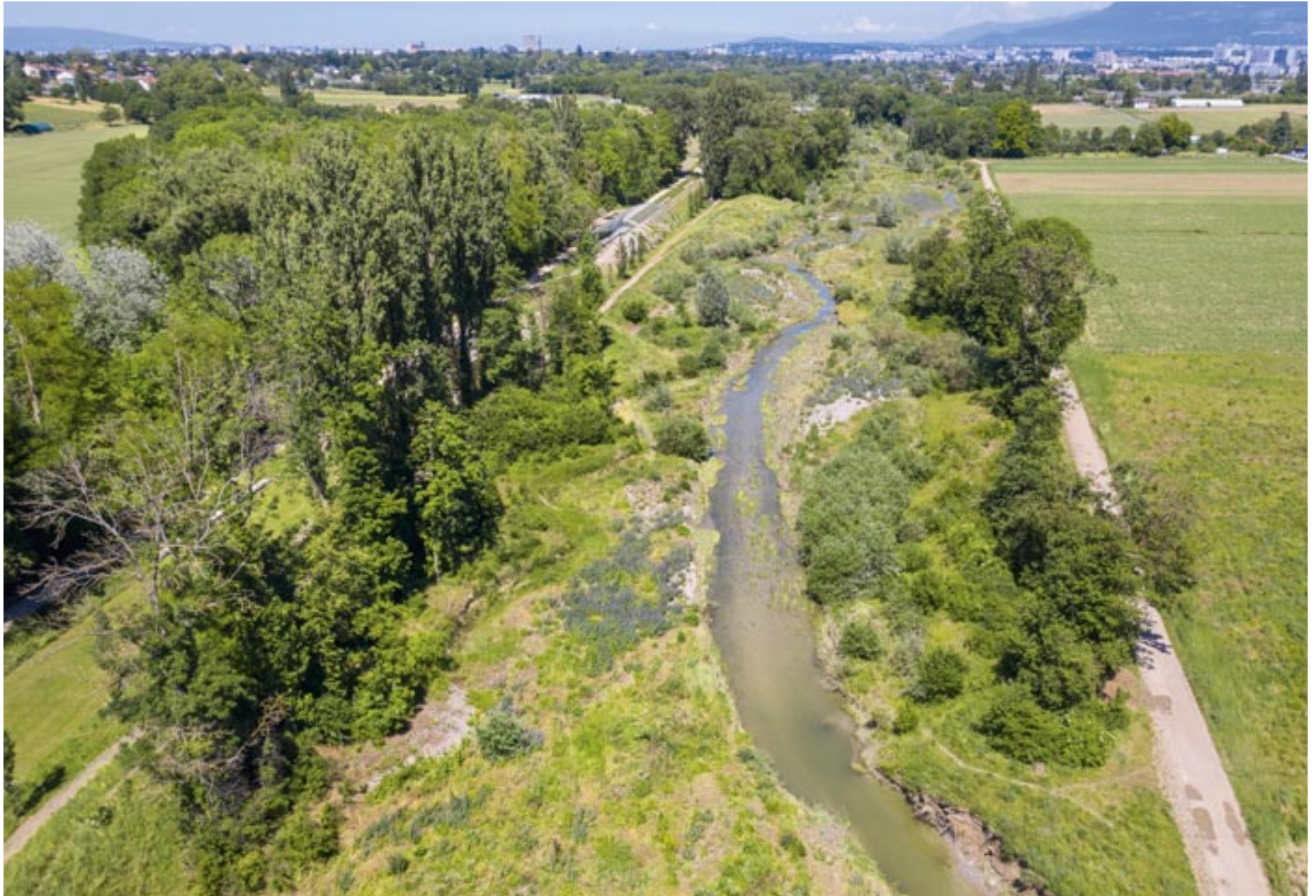
La technique de terrassement en losanges permet à la rivière de tracer elle-même son lit. Deux ans après les travaux ( image de gauche), et quatre ans plus tard
