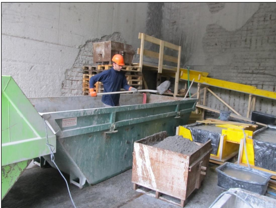
*Figure 2: Installation de lavage et récupération des métaux denses par gravimétrie construite pour le premier test de 2017.*
