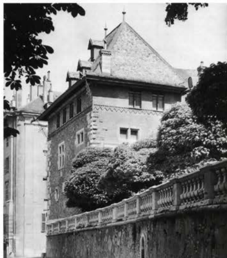
La tour Baudet avec son couronnement de briques domine toujours au sommet de la Treille. Elle appartenait à la Maison de Ville et assurait la défense de la porte du même nom qui permettait de pénétrer à l'intérieur de la cité.
