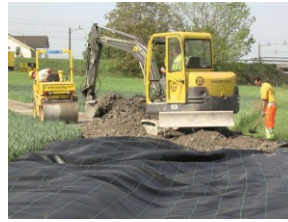
Mise en place d'une piste provisoire sur un géotextile.
