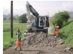
Déconstruction d'une piste.
