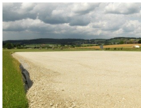
Aire d'installation de chantier préparée en disposant un matelas protecteur en gravier (solution préconisée).
