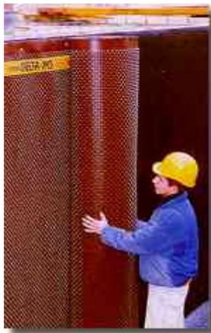
Figure 17 : Couche de protection de type DELTA-MS. (Source : Ecoservices, 2005)
