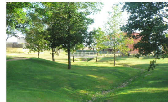
Noue paysagère - fossé peu profond pour recueillir l'eau de ruissellement
