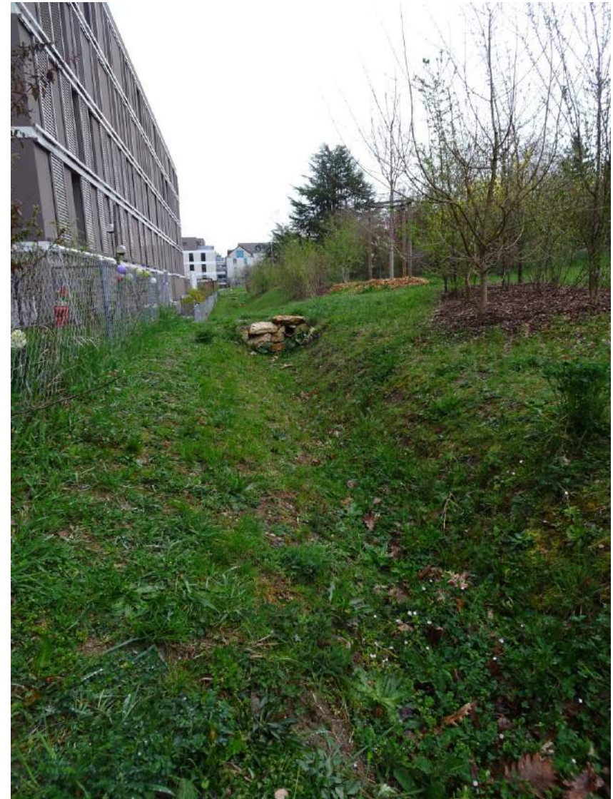
Noue de rétention
