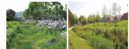
des noûes végétalisées et intégrées dans l'aménagement de l'espace public
