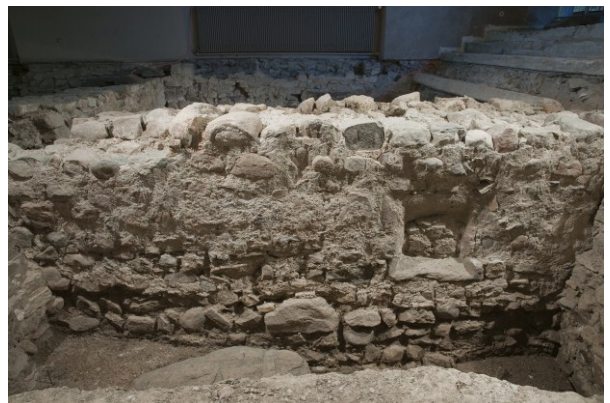
Fig. 12 Elévation extérieure sud du chœur gothique, avec sa petite fenêtre condamnée lors de l'établissement de la sacristie.
