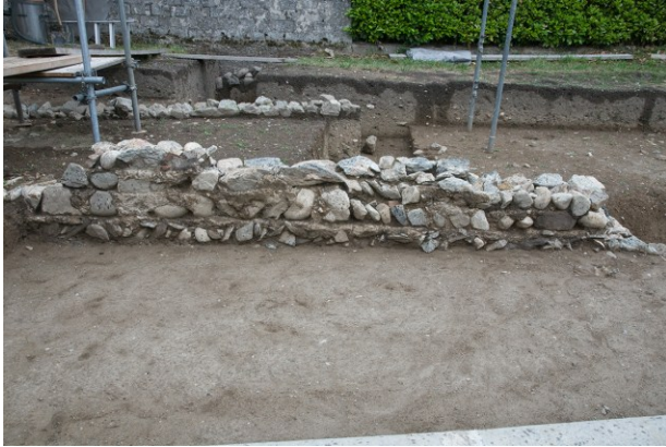
Fig. 6 Mur de séparation à l'intérieur du domaine, dont on perçoit une assise de fondation et trois d'élévation.
