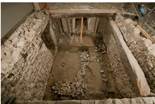
Fig. 11 Le cellier situé sous le chœur gothique était accessible de plain-pied par une porte aménagée à l'est, doté de deux petites fenêtres latérales (celle du nord a été transformée en porte), et d'un drain sous son sol de terre battue afin de collecter les eaux de surface.
