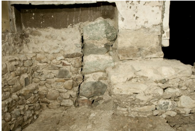
Fig. 13 L'angle sud-est de la nouvelle nef est marqué par un chaînage de grosses pierres contre lequel viendront ultérieurement s'appuyer les fondations de la sacristie (à gauche).
