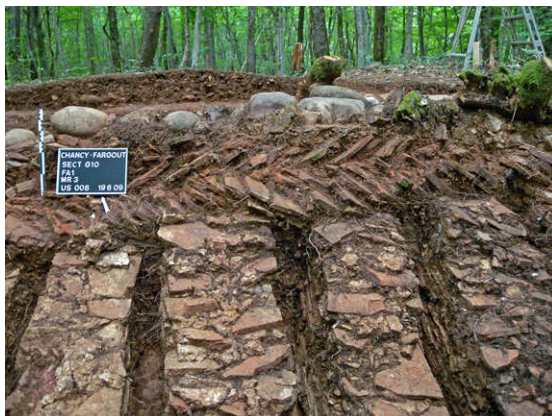
Fig. 6 Élévation de la structure et murs de soutènement du côté sud. Phases dites "en épi" et en moellons (photo G. Zoller, SCA).
