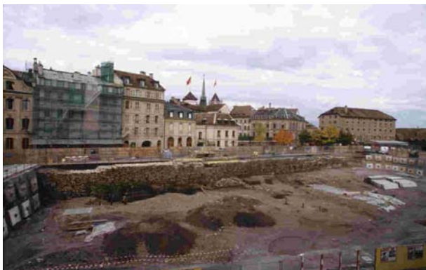
Vue générale des fouilles en direction du bastion de Saint-Antoine
