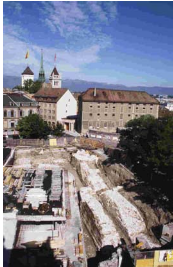
Dégagement de l'aile ouest du bastion de Saint-Antoine
