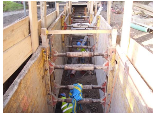
Remplacement d'un collecteur d'eaux pluviales sur le bas du chemin du Lac - Chantier 2012-2013 - Fiche action 1.3
