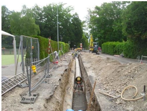
Remplacement d'un collecteur d'eaux pluviales sur le bas du chemin du Lac - Chantier 2012-2013 - Fiche action 1.3
