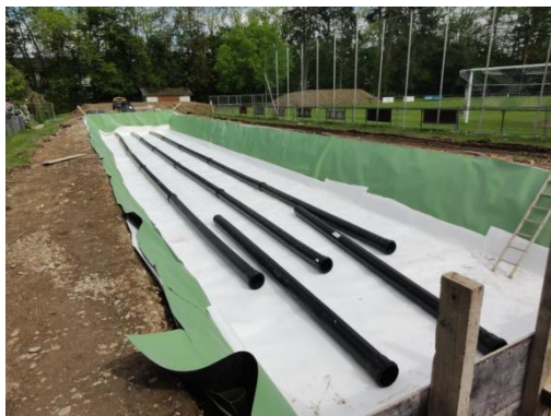
Réalisation du bassin de rétention des eaux pluviales de l'avenue Louis-Yung sur la commune de Versoix. Bassin enterré de type Nidaplast, volume 195 m 3 - Chantier de Mai à Juillet 2012 - Fiche action 1.2.
