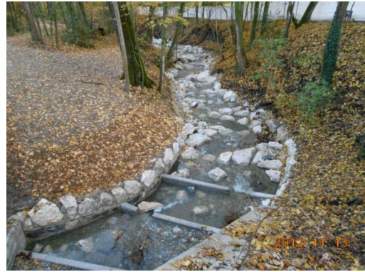
Nant de Braille, partie aval avant et après renaturation. Protection contre les érosions, reconnexion et reconstruction de la passe à poisson et suppression d'ouvrages illégaux - Chantier réalisé Juillet à Novembre 2012 - Fiche action 1.5.1
