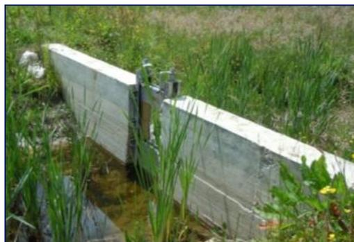
Figure 3: Système à batardeaux
