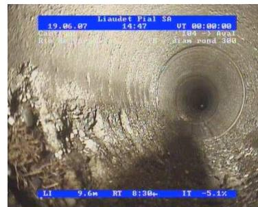
Dégradation du béton à la hauteur de la chambre EP 104.
