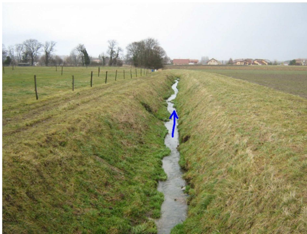
Canal de Beaupré, vue du chemin de Beaupré vers l'aval (France)
