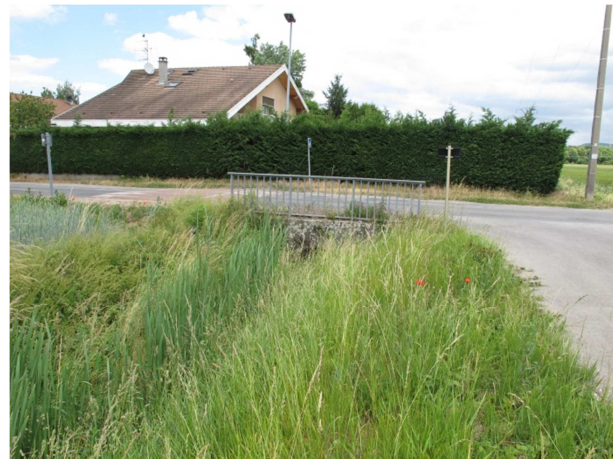
Canal de Beaupré, vue vers l'aval (route de Foncenex)
