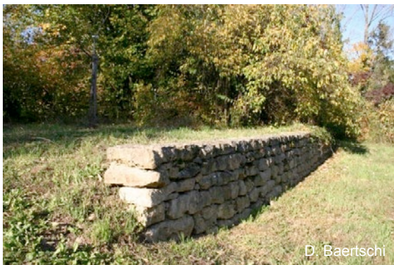
Mur de soutènement en pierres
