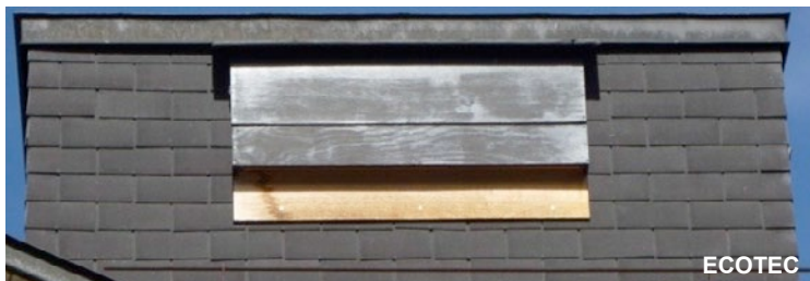
Nichoir « plat » multi compartiment installé sur le toit de l'arsenal cantonal, rue de l'Ecole de médecine, à Genève.
