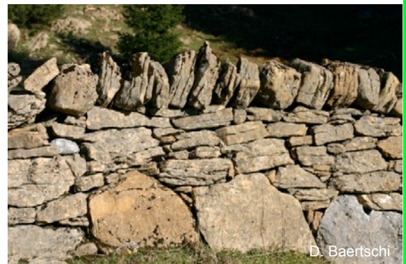
Détail de murs en pierres sèches
