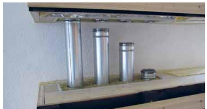
au-dessus des portes des chambres. Pour cela, la hauteur sous plafond dans le couloir doit pouvoir être réduite d'environ 15 cm. Selon les exigences architecturales et le concept, des plafonds suspendus ou des conduits visibles sont réalisables.
