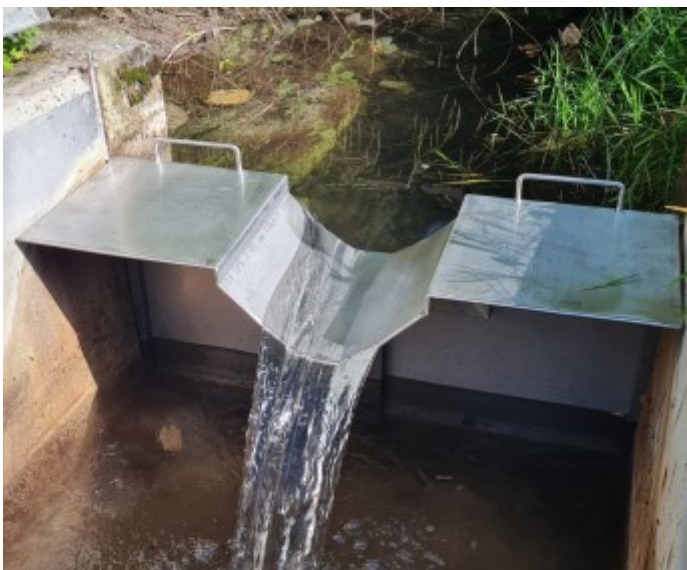
Barrière à écrevisses sur le ruisseau des Eaux-Chaudes
