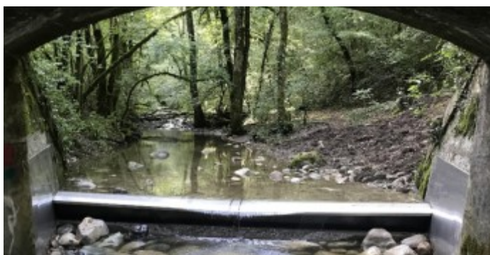
Ouvrage de protection de l'Écrevisse à pattes blanches sur le Roulave
