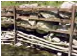
Travaux de stabilisation des berges sous Soral, réalisés dans les années 80.
