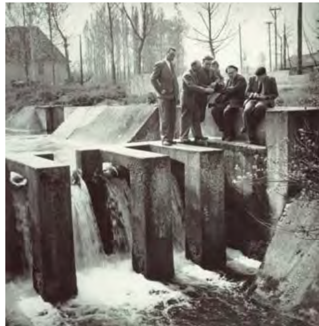
Canalisation de l'Hermance à Veigy (1960).
