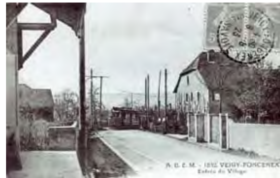
Entrée du tram dans le village de Veigy-Foncenex.
