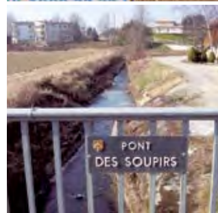
Canalisation de l'Hermance et urbanisation à Veigy.
