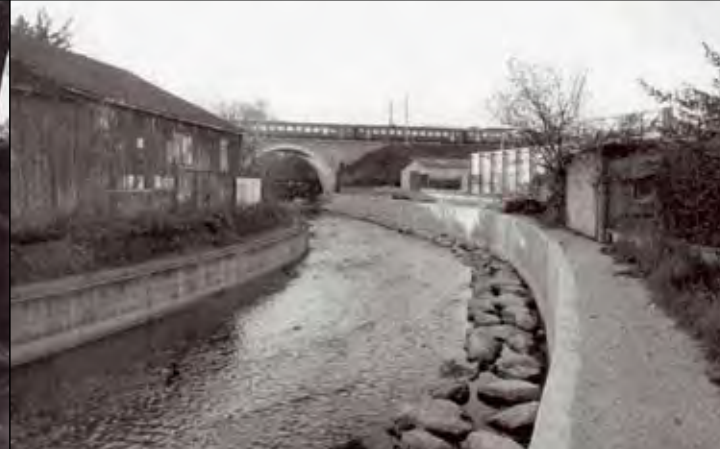
Les travaux d'endiguement de la Versoix réalisés au siècle dernier.
