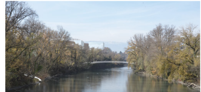
Vue du pont Hans-Wilsdorf
