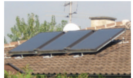
Pose en adjonction des installations de panneau solaire sur console:
