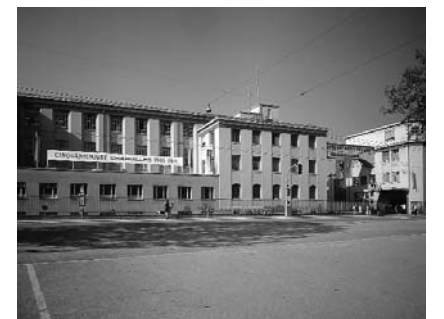
Le front sur rue de l'usine, avec sa passerelle emblématique reliant les bâtiments administratifs, 1971 (CIG).
