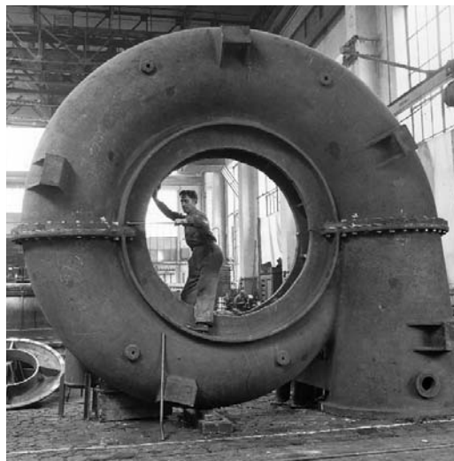
Une bêche à eau pour turbine Francis en cours de montage, vers 1950 (CIG). Les turbines sont conçues pour un débit et une élévation spécifiques, interdisant toute fabrication en série.
