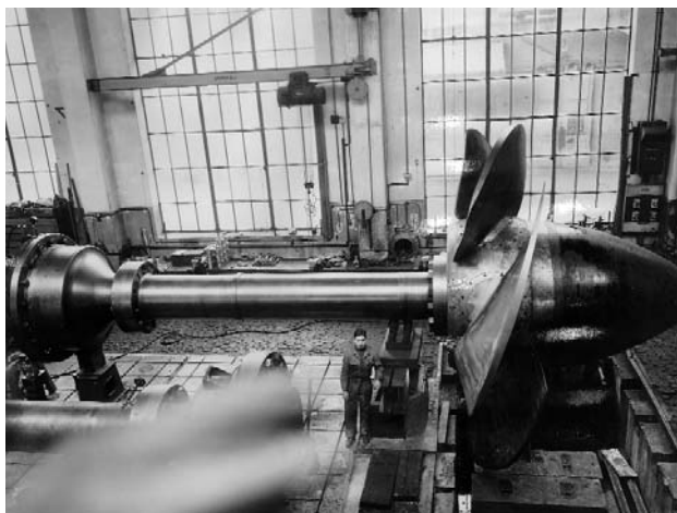
Un appareil pose devant l'une des trois turbines Kaplan de 32 000 CV de la future centrale de Verbale, vers 1942 (CIG).
