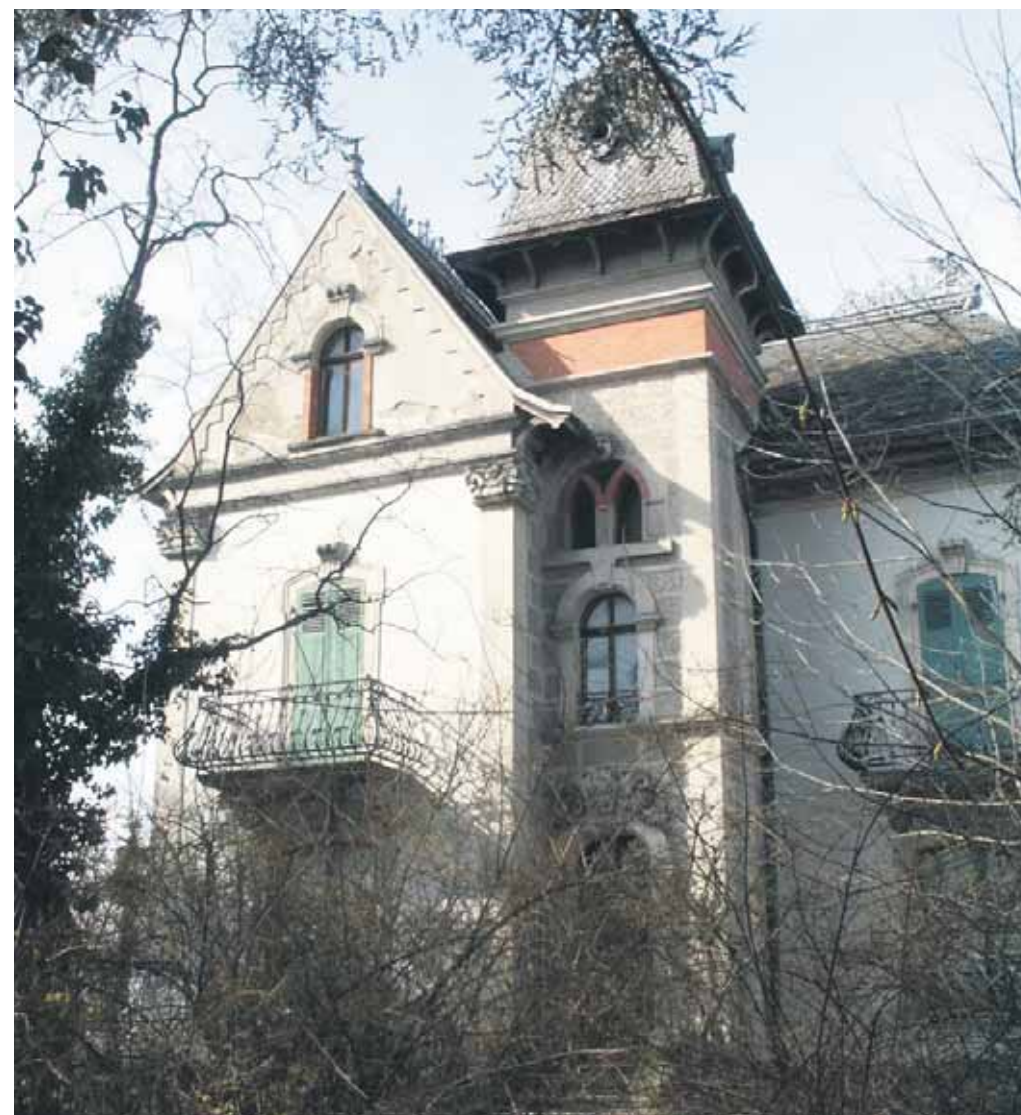
Maison de maître du futur lieu de vie intergénérationnel.
