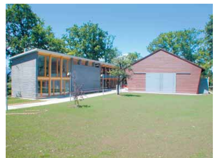
La salle de spectacles de l'Epicentre (epicentre.ch), dont la scène peut s'ouvrir sur l'extérieur. A gauche, le bâtiment accueillant des associations culturelles et le Point d'interrogation. (Photos MC)
