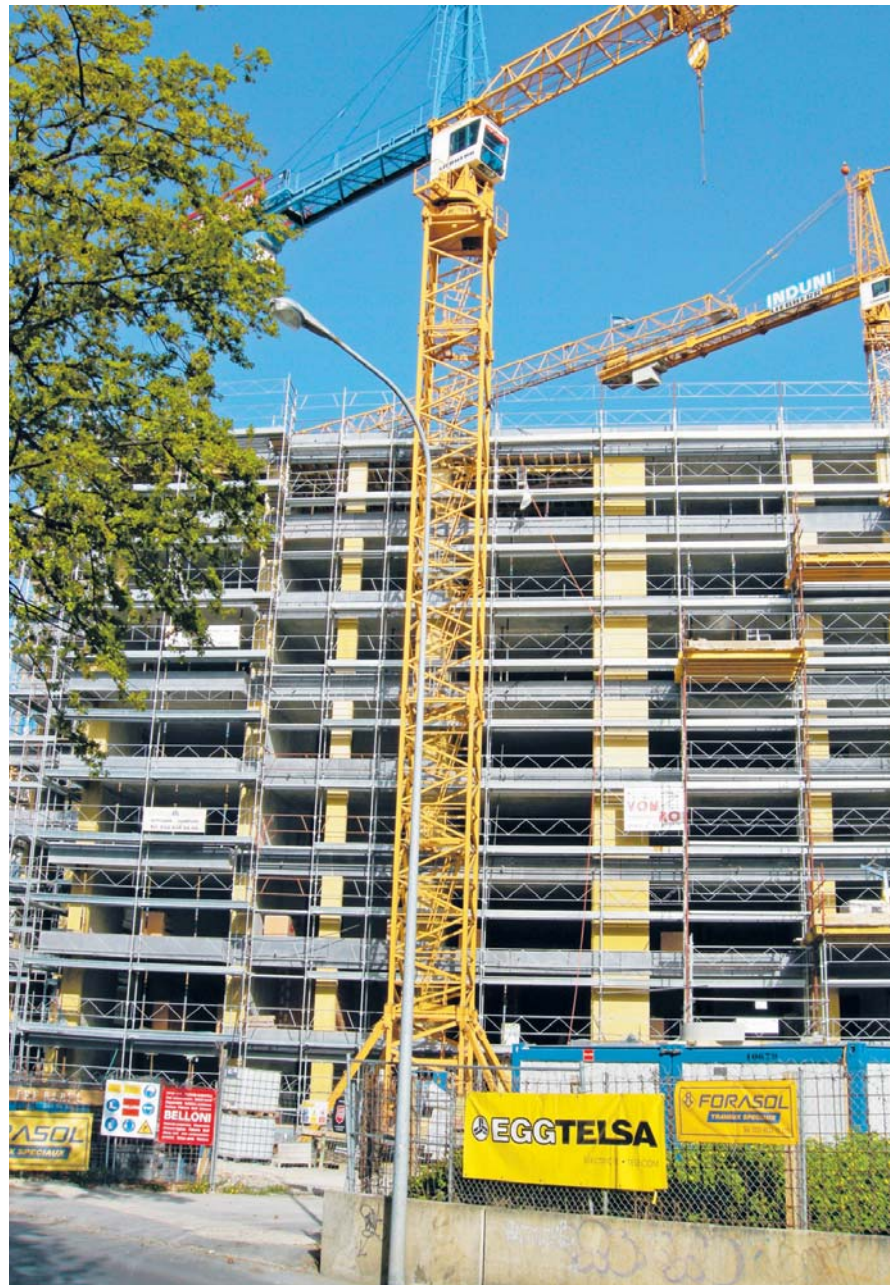
Construction de Pré-Babel II, chemin de Grange-Canal, photo : F. Montanya.
