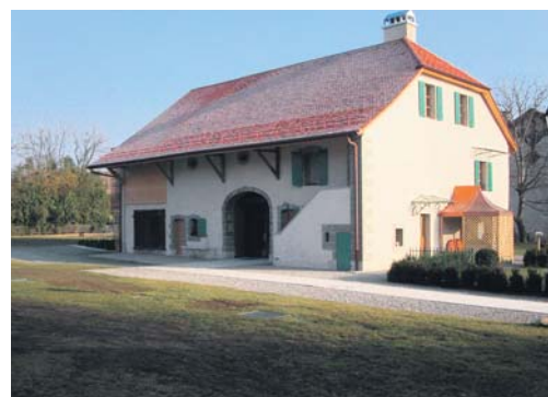
La nouvelle Maison communale
