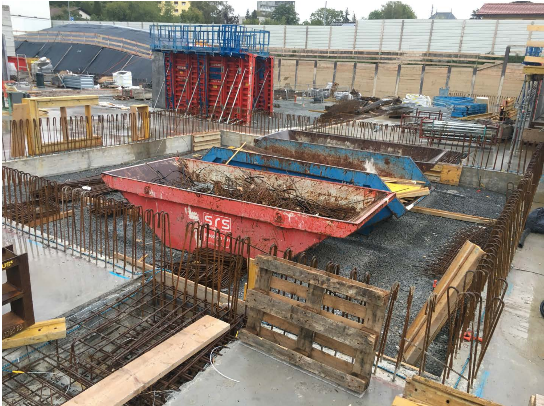
les débuts de la fosse le 27 septembre 2022
