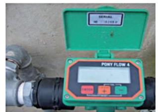
Photo 4 : compteur volumétrique électronique (G. Fiaux, 2007)
